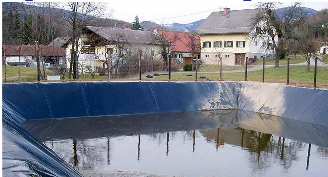
Angeboten werden unter anderem Kunststoff-Abdichtungen für Güllelagunen, Speicherteiche, Biotop, Pools, Flachdächer. Sanierungen von Altgüllegruben und Abdichtungen für Regenwasserbehälter. Und auf Grund langjähriger Erfahrung kennt Fa. Fuchs die Vorteile von Kunststoffabdichtungen, die in jeder Größe angeboten werden, ganz genau: Zum einen ist Kunststoff die preisgünstigste Variante, dazu kommt der rasche Einbau, bei Bedarf ist auch ein Rückbau oder eine Erweiterung jederzeit möglich.
